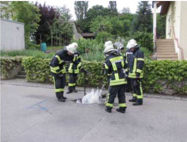
Hydrantenkontrolle
